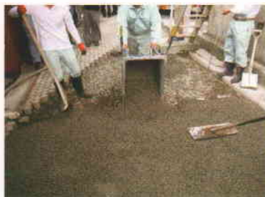
施工中・・・
