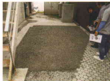
施工開始より30分で完成！
